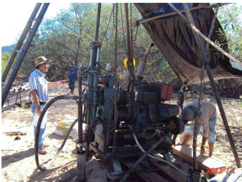
Foto 17: Vista da sondagem mista realizada no eixo da barragem Inhuçu
